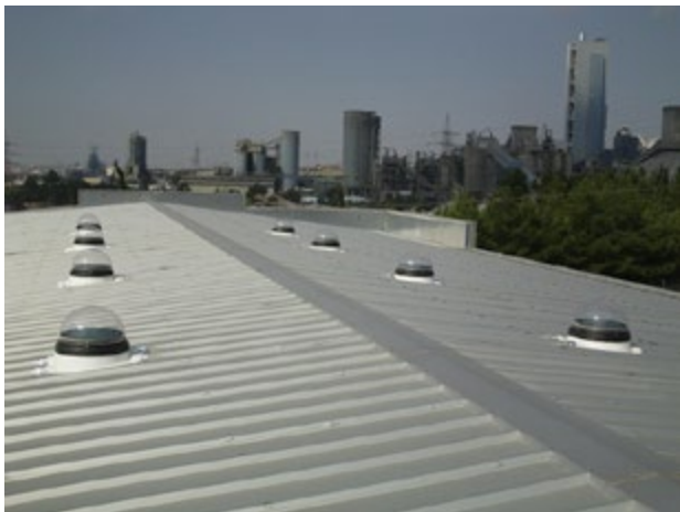
LW 600 & LW800 diam. 520mm & diam. 760mm
